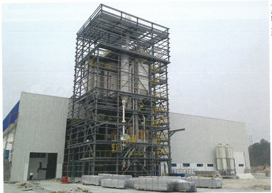
Pro Stunde werden hier 35 Tonnen Kleber- und Spachtelmasse produziert.
